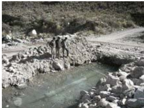
Derrame del mineraloducto (en este caso, en Villa Vil).
